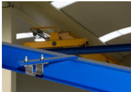
PLATINES SOUDES A LA POUTRE
